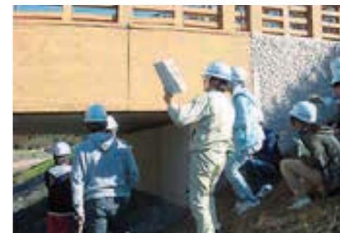
将来の専門技術者（本学学生）を対象とした橋梁点検研修会の様子
