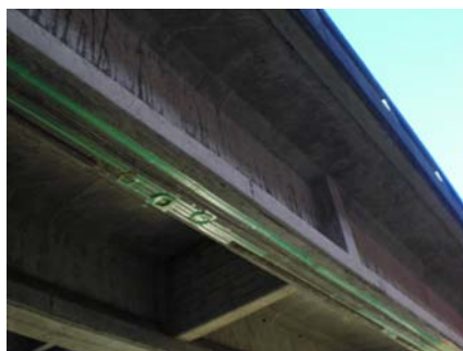
図-22 使用センサおよびセンサ敷設状況
