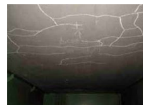
例：ひび割れの補修
