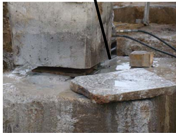
コンクリート柱切断
