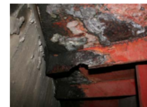
例：部材の取替え
